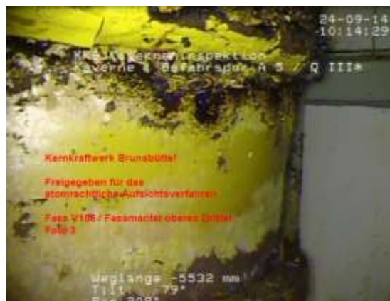
Ansicht oberes Fassdrittel mittels Inspektionskamera
