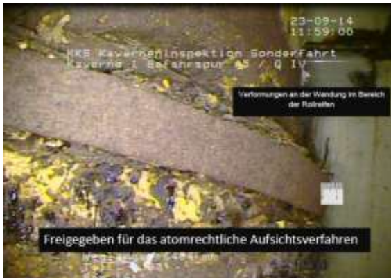
Das verformte Fass in der Kaverne 1 (© KKB)
