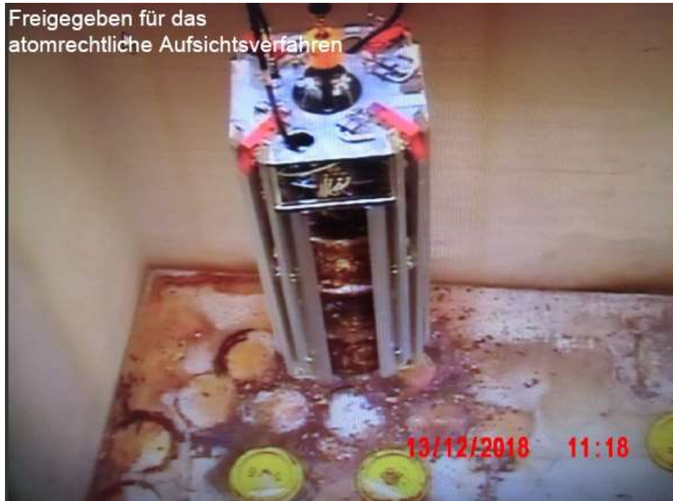
Das letzte Fass, V108, mit Konzentraten wird aus den Kavernen des KKB mit dem Umfanggreifer geborgen. (© KKB)
