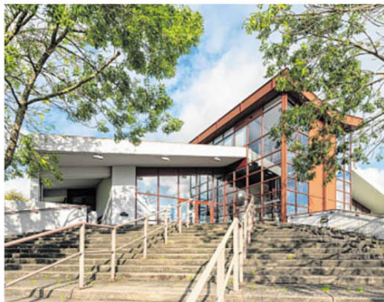
Besucherzentrum auf drei Etagen: Neben der breiten Treppe führt eine Rollstuhlrampe nach oben. Innen gibt es einen Fahrstuhl.
